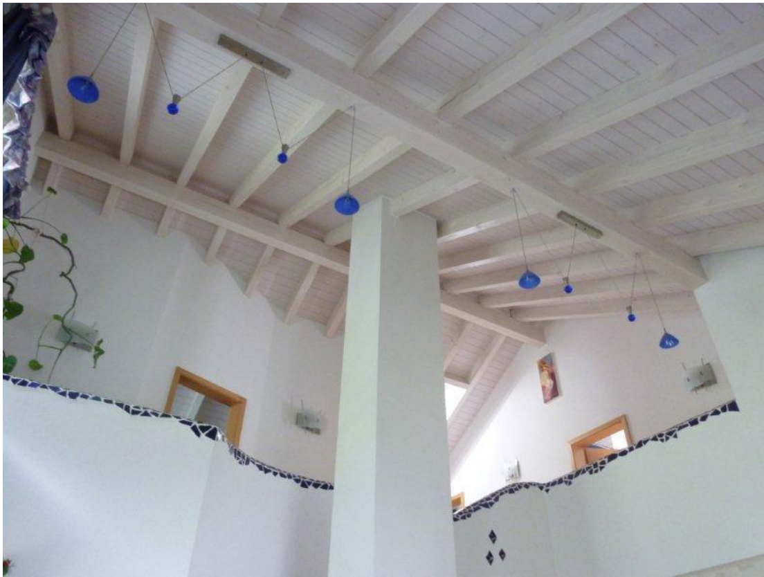
(Hohe Räume mit Sichtbalken)
